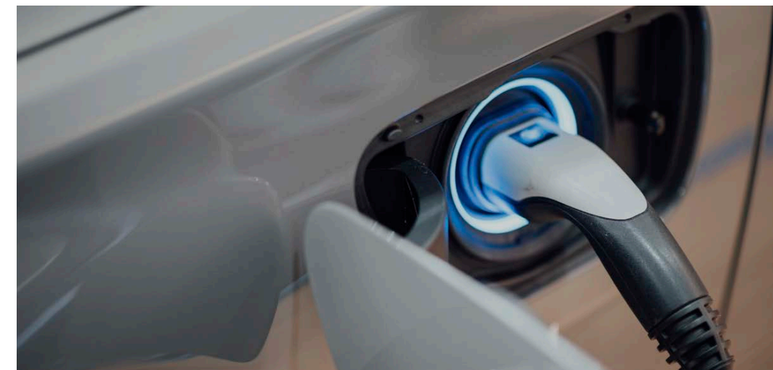
Зарядные станции в подземном паркинге для электромобилей 250 кВт
